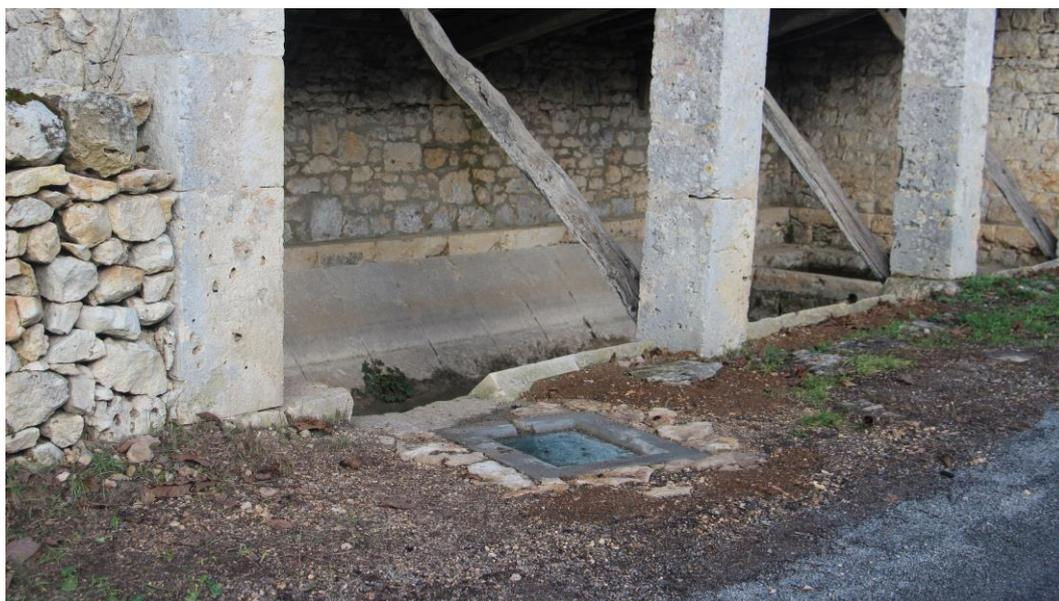
Suite à un affaissement provoqué par la rupture d'un dalot (VIC 133 1/2°) l'exutoire du lavoir d'Ourtriols nécessite une réfection. Le caniveau en pierre sera conservé et busé avec du PVC diamètre 250mm recouvert de grave ciment +enduit superficiel bicouche. Une vitre panoramique permet de voir l'ancienne construction de l'aqueduc en pierre de taille.
